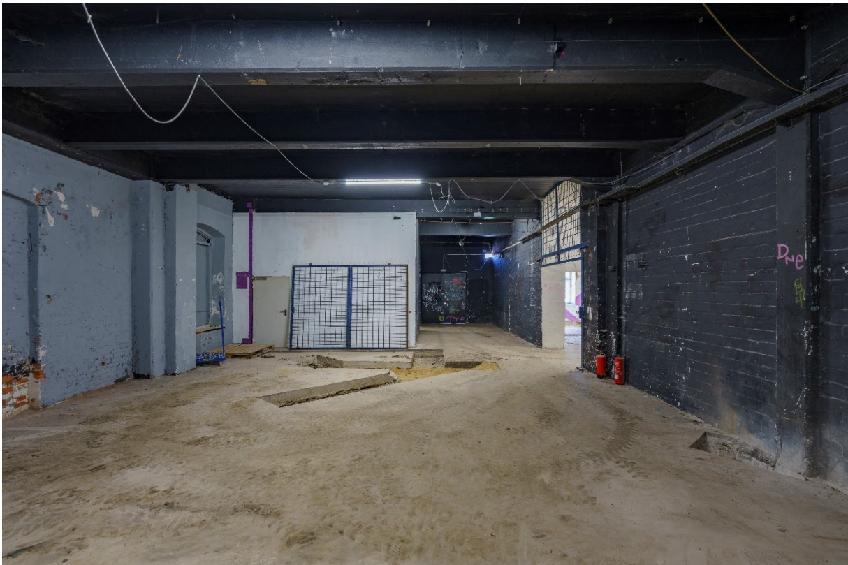
Abbildung 6: Im Umbau befindliche Nebenfläche der Mieteinheit in der Alten Bahnmeisterei (EG) © Miguel Ferraz
