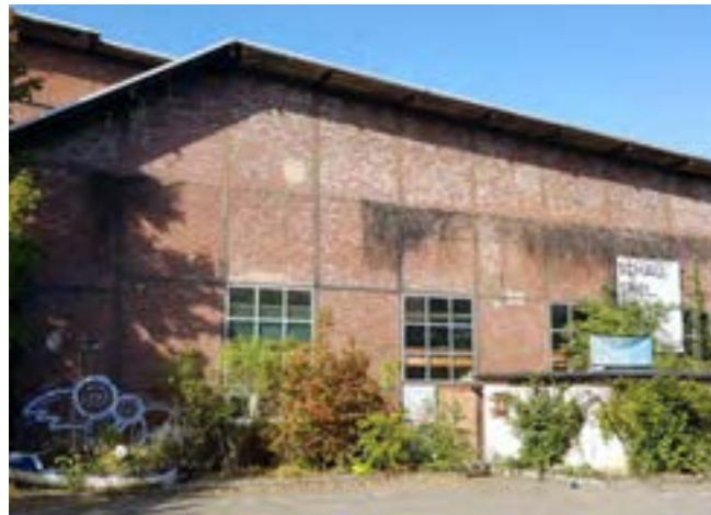
Abb. 8: Außenansicht der nördlichen Halle
